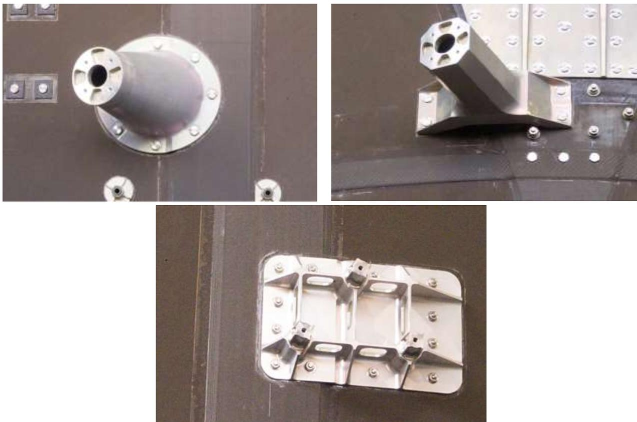
Рис. 2. Установка кронштейнов с частичным перекрытием продольных усиливающих элементов
