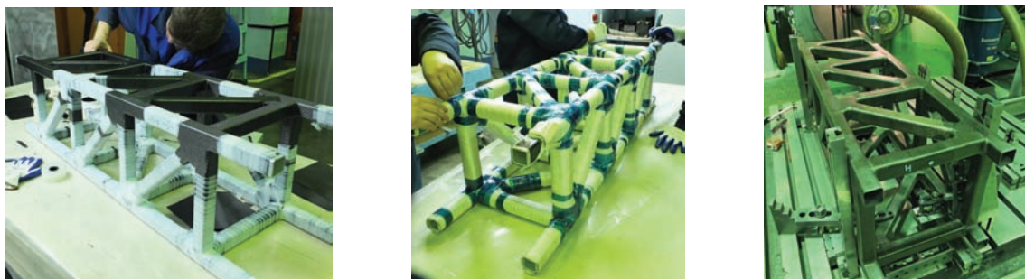
Рис.3. Процесс изготовления фермы из ПКМ
